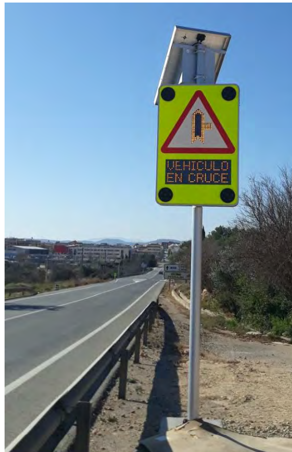
Señal de advertencia dinámica en carretera CV-50 pk 76+000.
